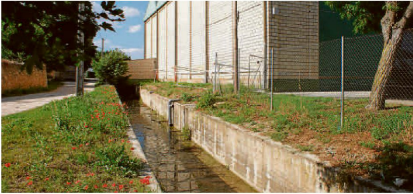
El tramo que se va a cubrir del arroyo de Moriscos a su paso por Aldealengua. | ENE
