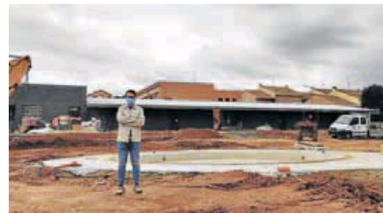
Las obras de la piscina van a buen ritmo y se abrirán en verano. WORD
