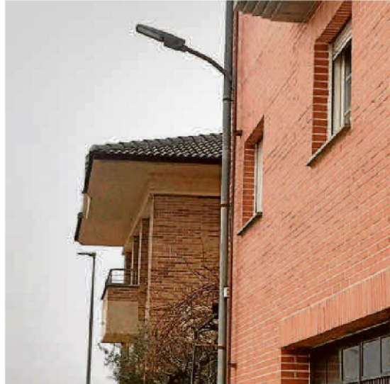
Las farolas ya lucen las nuevas luminarias con tecnología led. | ENE
