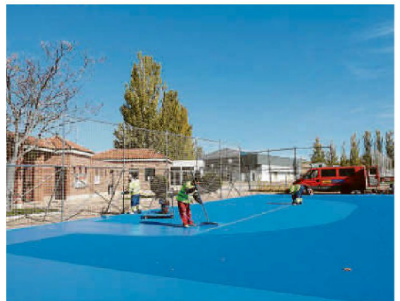
Los trabajadores ultiman las obras en las pistas del complejo exterior. | EÑE
