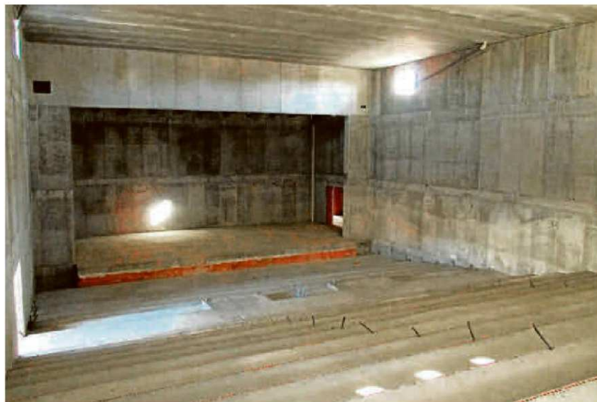
Estado actual de la obra en el espacio reservado para auditorio con escenario y gradas. | ENE
