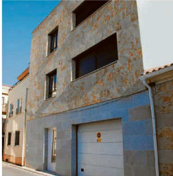
La obra del edificio está inacabada en su interior. | EÑE
