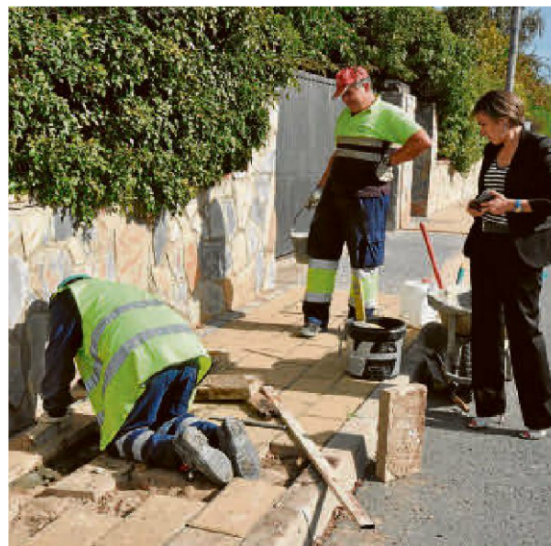
Uno de los trabajos realizados en Aldebarán. | ENE
