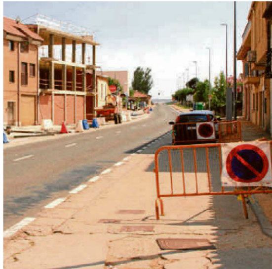
El Consistorio urbanizará el último tramo de la travesía de la CL-512. | ENE
