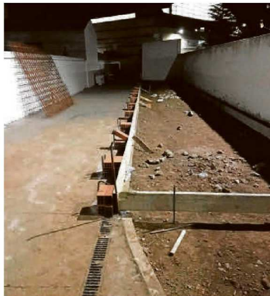
La empresa ha iniciado la construcción de los nuevos nichos. | EÑE
