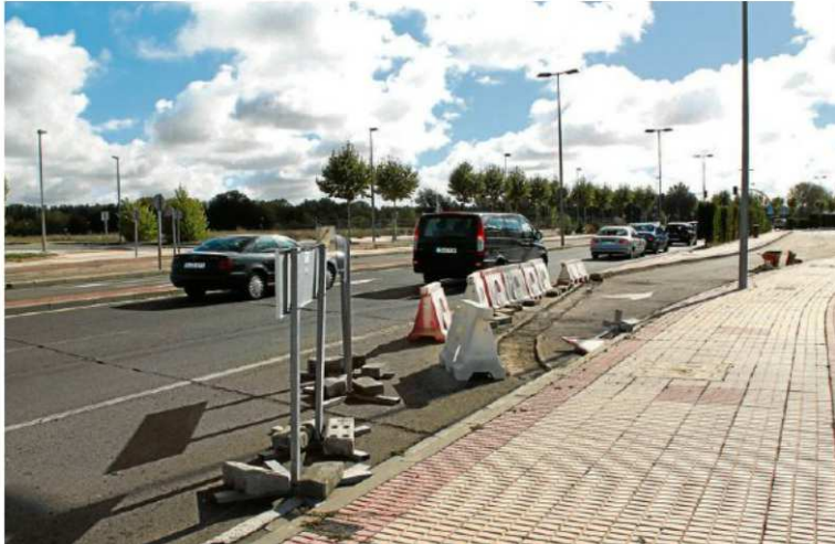
La barrera quedará eliminada definitivamente esta semana con hormigonado para evitar el paso. | ENE
