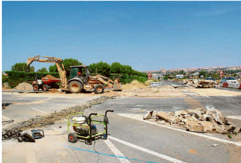
Las obras de construcción de la nueva rotonda de acceso por la carretera CL-510. | EÑE
