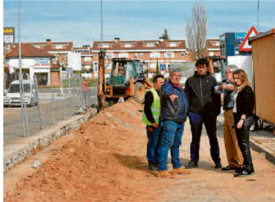
La edil del área junto a los operarios que ejecutan el cambio de tuberías. | EÑE
