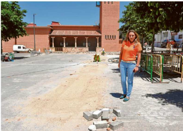
La concejala de Fomento, Marta Labrador, visitó las obras de renovación de redes en la plaza de la Iglesia. | ENE
