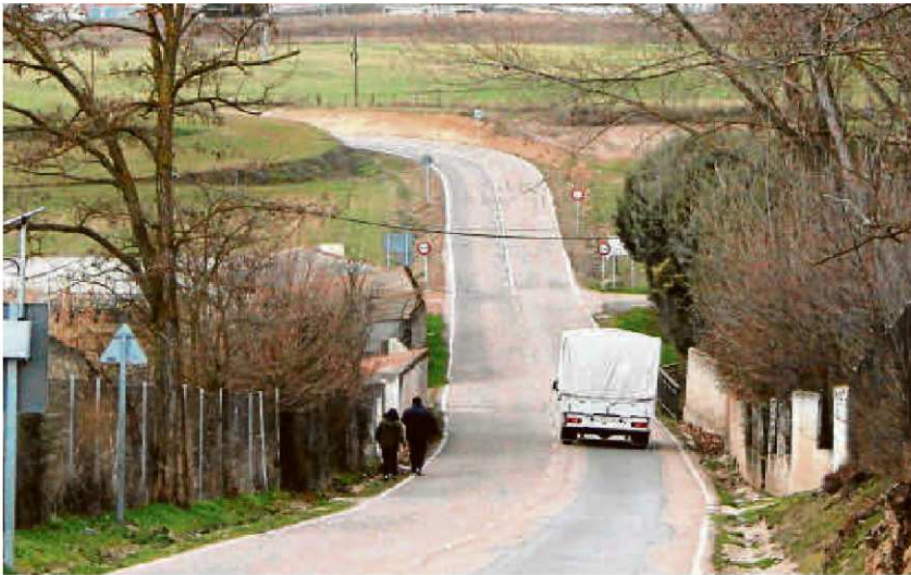
Los peatones que cruzan por el camino de Salamanca tienen que invadir la carretera, al no tener arcenes. | EÑE
