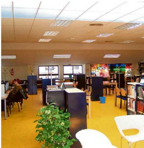
Las goteras son continuas en la sala general de la Biblioteca Municipal. | ENE
