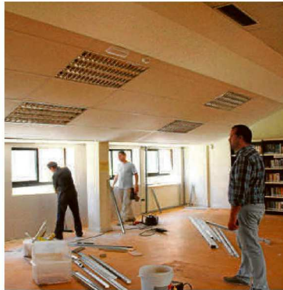
El alcalde, David Mingo, visitó el inicio de las obras de la biblioteca. | ENE
