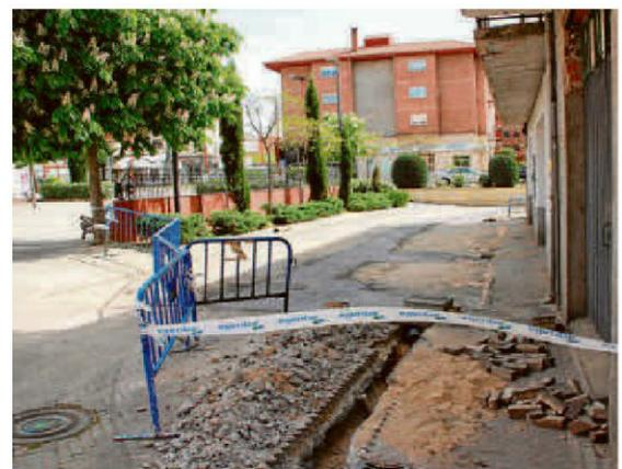
Obra de renovación de la tubería de pluviales en la plaza de la Iglesia. | EÑE
