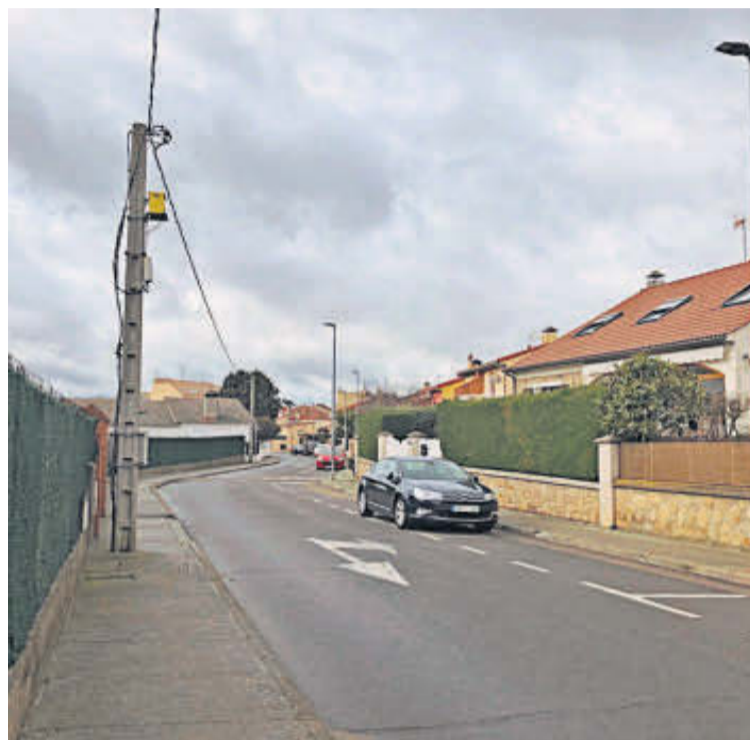
Las obras incluyen la renovación de aceras y soterramiento de cables. | EÑE
