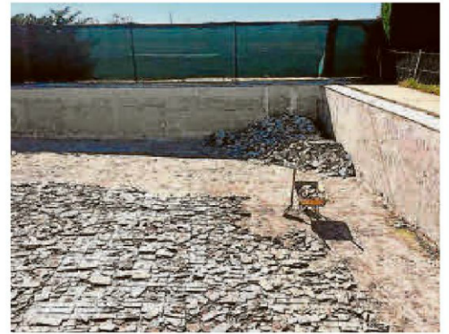
El inicio de las obras de las piscinas de Aldeanueva. | EÑE
