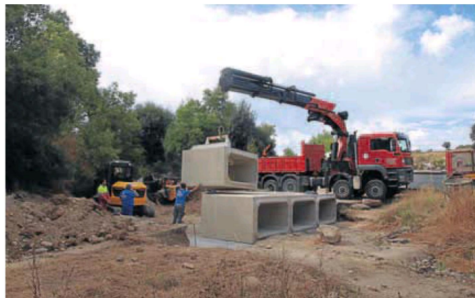
Trabajos de construcción del nuevo puente. WORD
