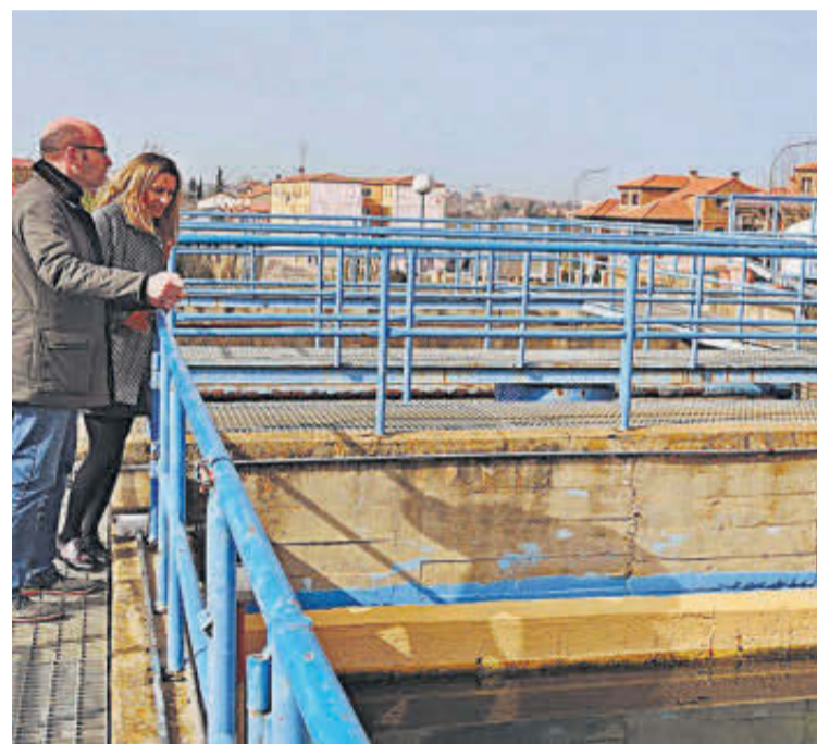
El Ayuntamiento renovó hace un año los filtros de la depuradora. | EÑE
