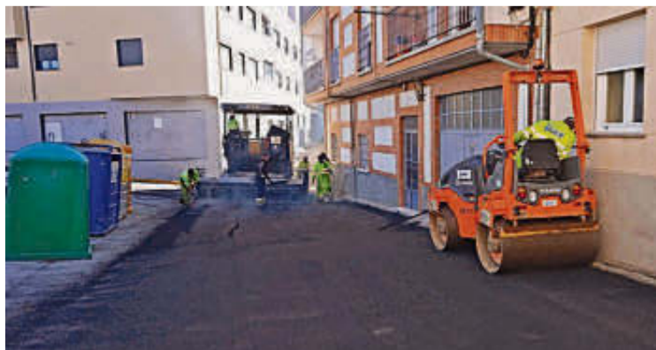
Las tareas de asfaltado en la zona de la calle Hospital. | EÑE
