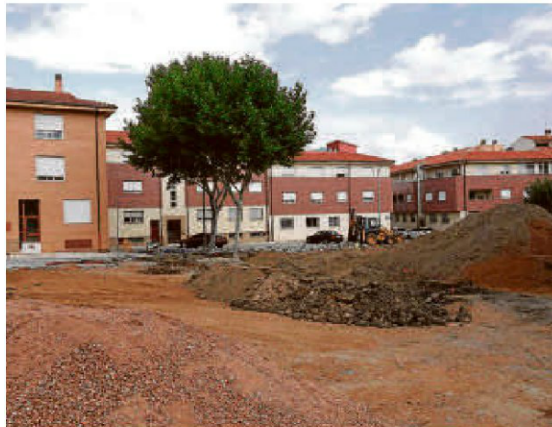
Inicio de los movimientos de tierra del futuro parque de la calle Pinilla. | ENE
