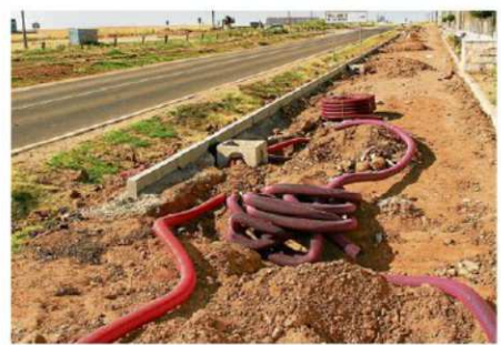
Las obras se están realizando en la carretera de Aldeaseca. | ENE
