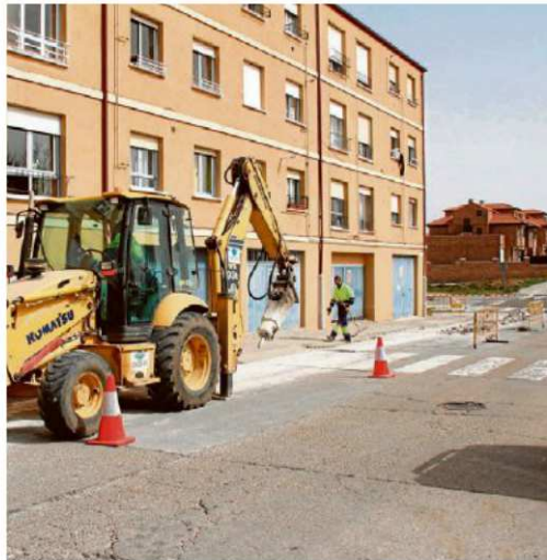
Las obras de renovación de redes han cortado al tráfico la calle Unicef. | ENE
