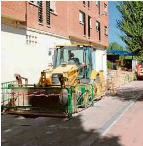
Las nuevas tuberías evitarán las roturas en la zona antigua de la red. | EÑE
