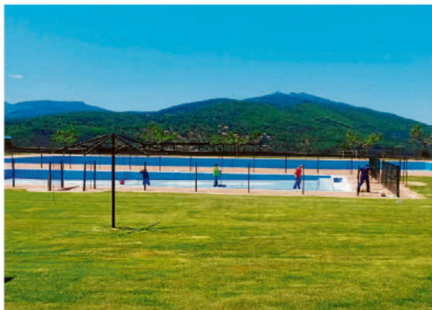
Trabajo de preparación de las piscinas de La Carrallana de Béjar. | TTT
