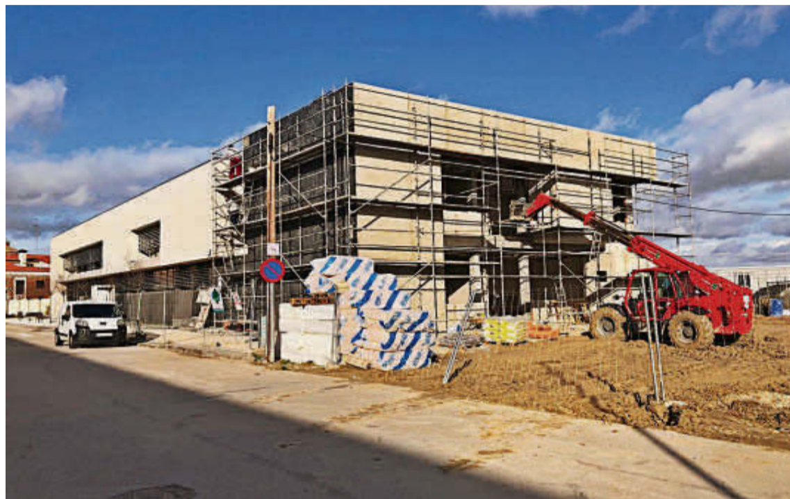
La tercera fase de las obras del colegio de Castellanos de Moriscos se está ejecutando ahora. | EÑE
