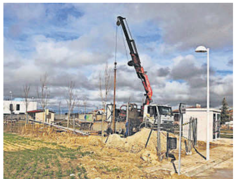
Las obras del sondeo que se están ejecutando junto al merendero. | EÑE
