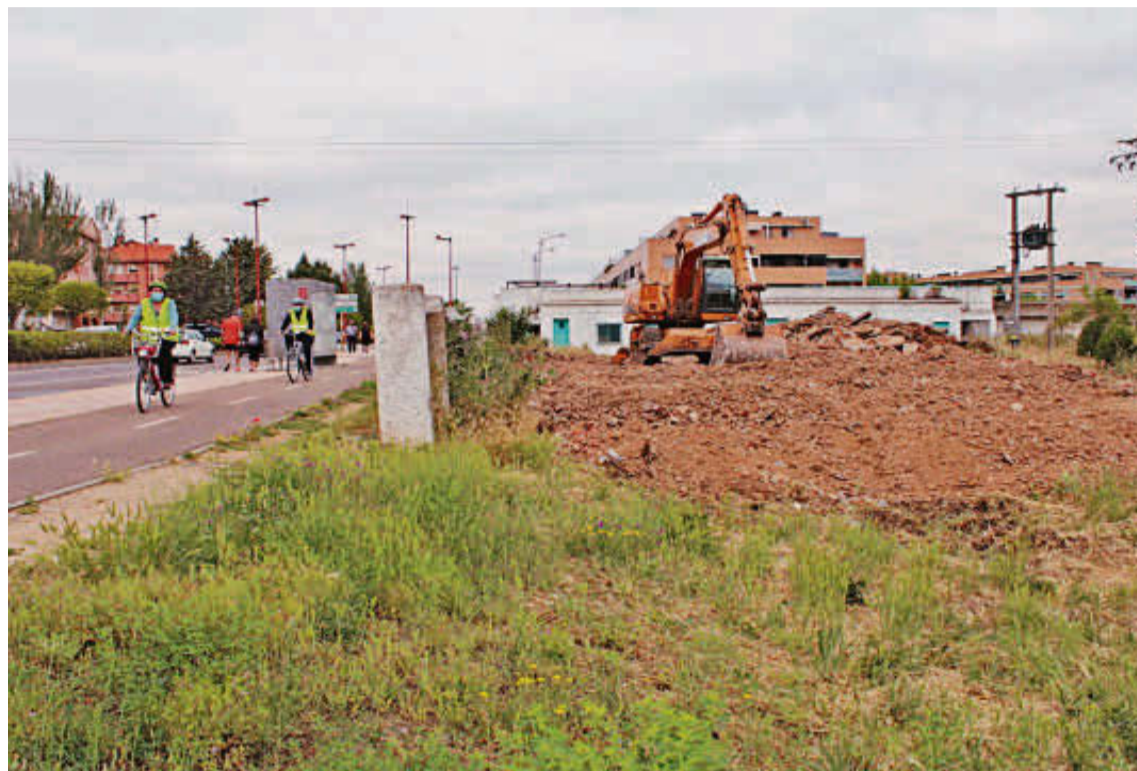
Los trabajos de demolición de las tapias de la vieja depuradora frente al matadero de Santa Marta. | EÑE
