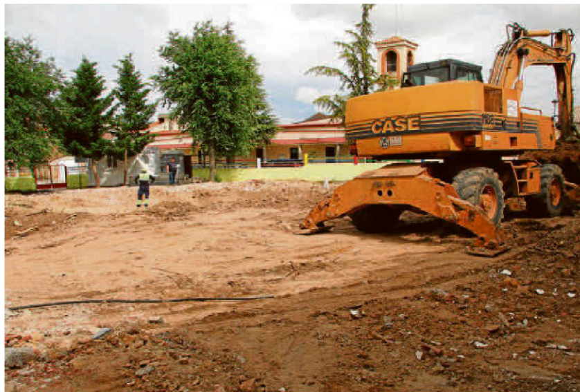
Las máquinas ya han comenzado las excavaciones en el solar del futuro edificio multiusos. | EÑE
