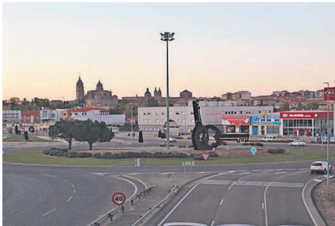
El asfaltado eliminará los baches y fisuras en el pavimento de la gran rotonda de Las Llaves. | EÑE
