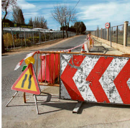
Las obras en el Camino de los Frailes. | EÑE
