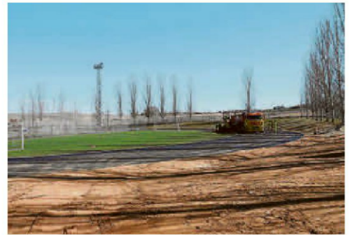
Obras de pavimentación del complejo deportivo. | EÑE
