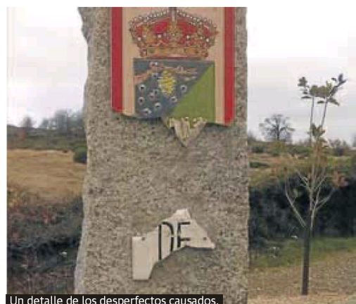
Un detalle de los desperfectos causados.
