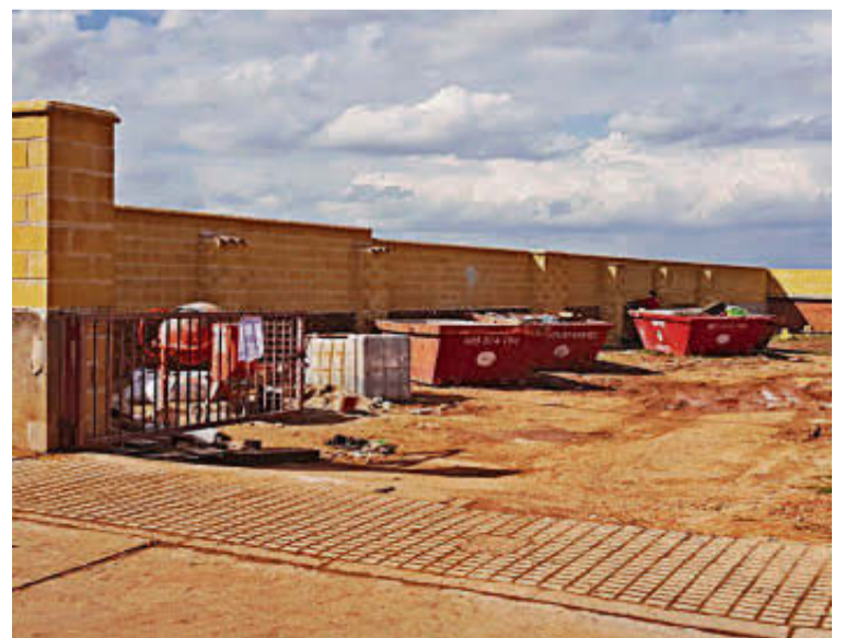
Las obras del futuro Punto Limpio de Doñinos. | EÑE
