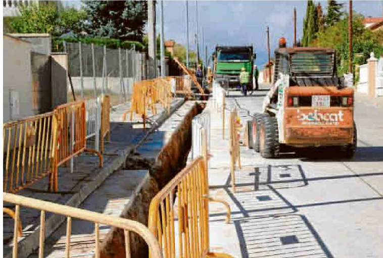
Las obras para llevar las canalizaciones de gas a los centros educativos. | ENE
