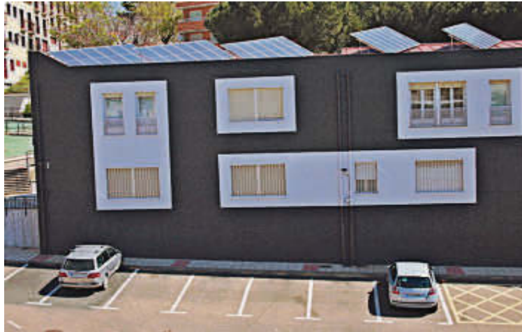
Las placas solares instaladas en la Casa Consistorial de Cabrerizos. | EÑE
