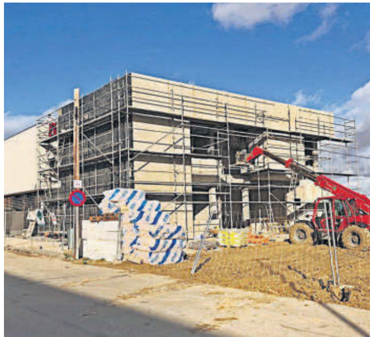
Estado de las obras de ampliación del colegio de Castellanos. | EÑE
