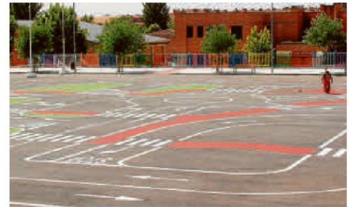
Los operarios ultimán la señalización del nuevo circuito vial. | EÑE
