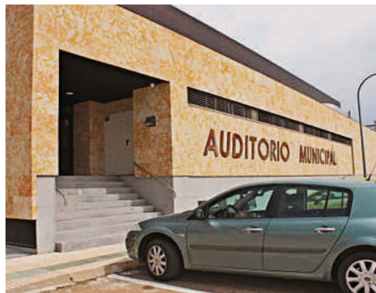
La salida de emergencia del auditorio municipal tendrá trapa de cierre. | EÑE
