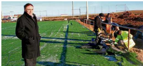
Los operarios ultimán la instalación del césped artificial. | ENE
