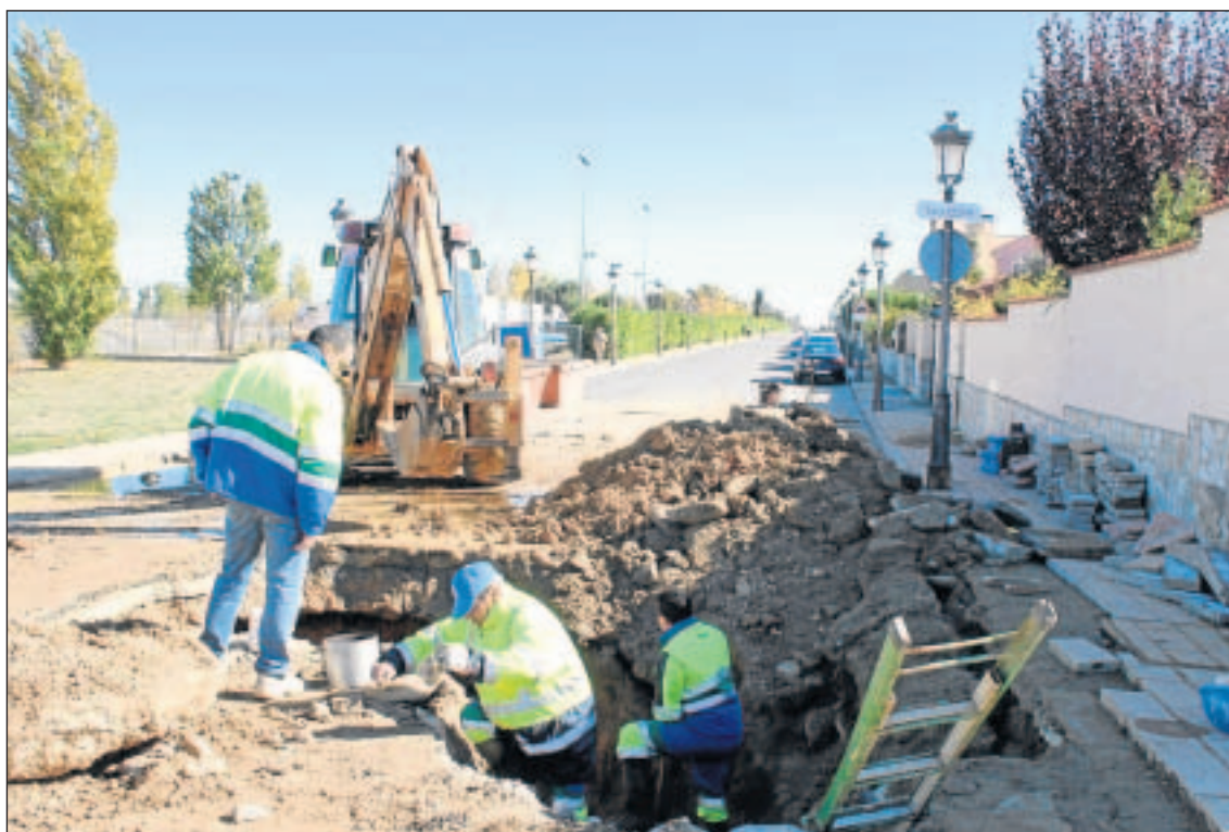
Imagen de los operarios en la avenida de Aldebarán durante las labores de arreglo de la tubería. MARJÉS
