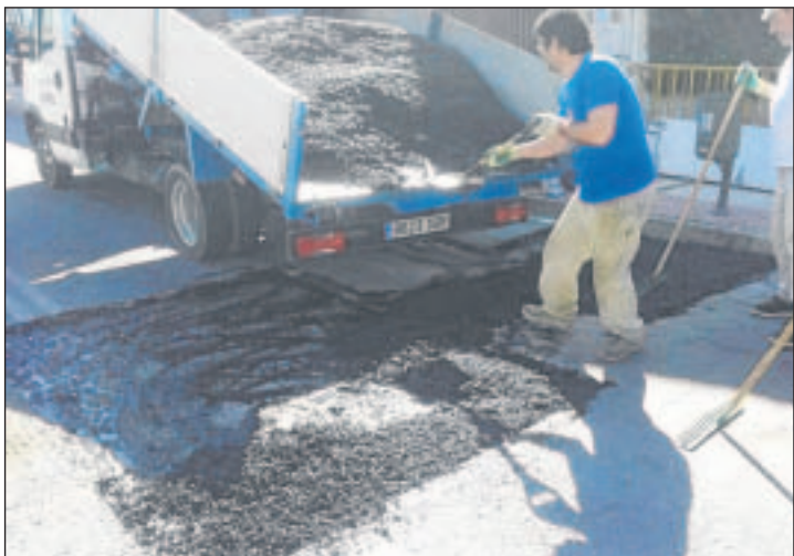
Los operarios del Consistorio realizando los trabajos de eliminación de baches. MARJÉS
