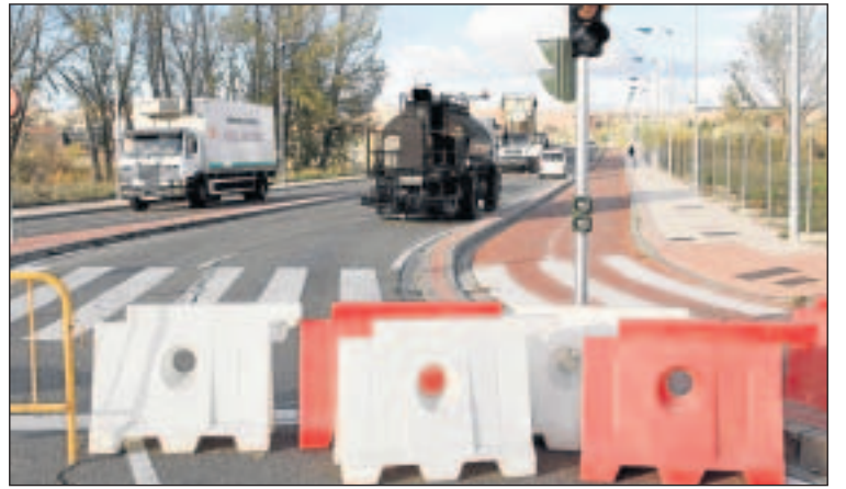
Una máquina realiza las obras de asfaltado en el puente Juan Carlos I.
