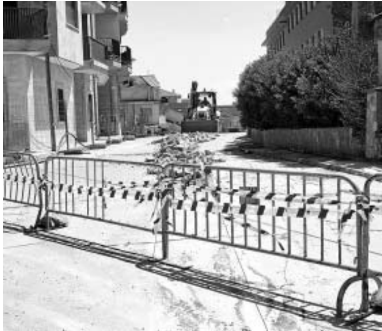
Las obras para renovar los servicios básicos acaban de comenzar./EÑE
