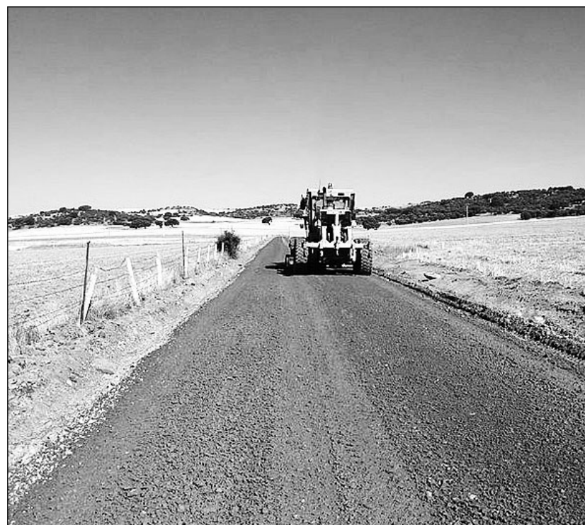
Aspecto actual del camino vecinal entre Sieteiglesias y Buenavista / JIMÉNEZ
