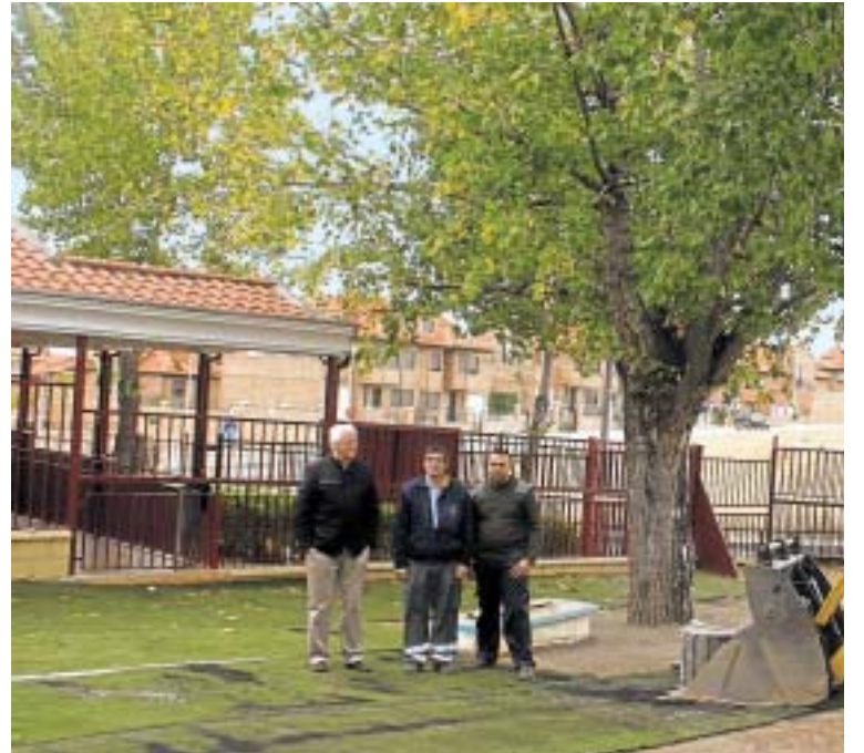
El edil de Mantenimiento visitó las obras en el patio del Miguel Hernández./EÑE
