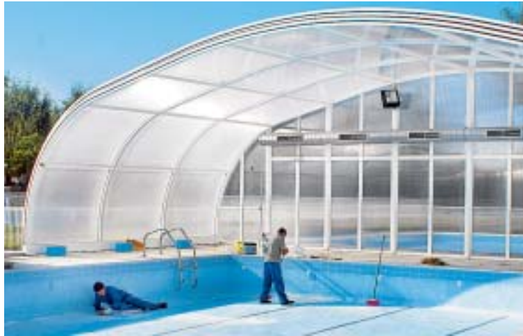
Los operarios realizan la reparación y la limpieza de la piscina./EÑE
