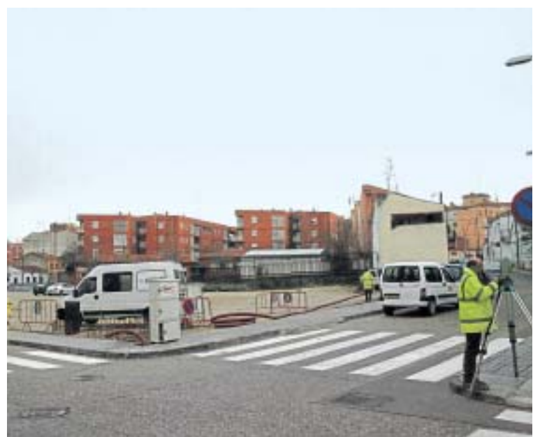
Los operarios realizaron ayer las primeras mediciones antes de iniciar la obra./EÑE
