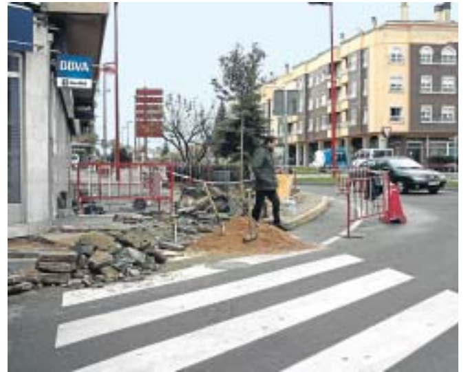
Los trabajos se encuentran al final de la travesía de Madrid./EÑE
